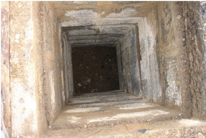
puits de mine
